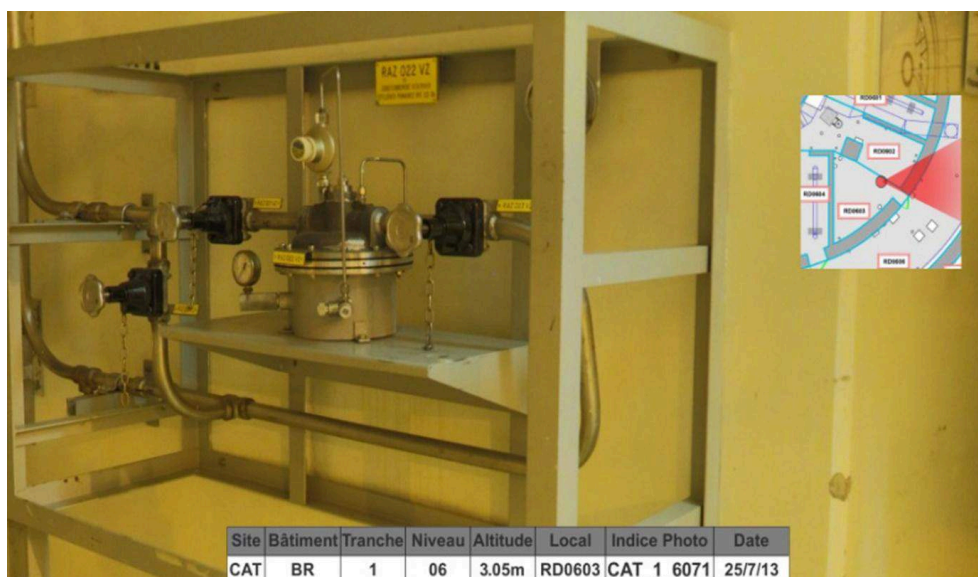
Figure 6 : Détendeur pilote que les stagiaires devaient trouver dans leur enquête.
